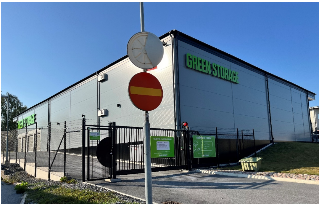
Figur 7. Vy längs Svetsarvägen mot fastighet Veden 103.
