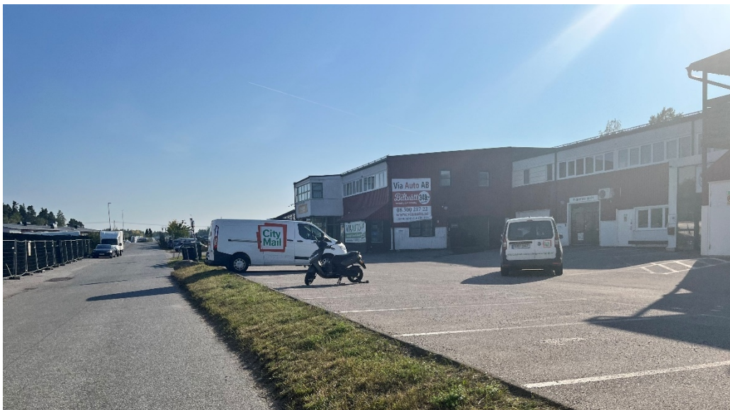
Figur 4. Vy längs Eldarvägen mot fastighet Oljan 2.
