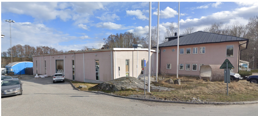
Figur 5. Kontors- och fabriksbyggnad inom Flygkompassen 1. Till vänster syns ett blått tält inom Höjdmätaren 1.
