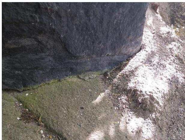
Figur 7. Mindre byggnad gjutet på berg
