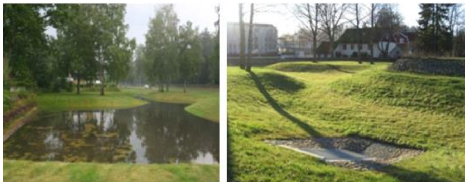
Figur 13. Skålade/nedsänkta grönytor vid vått respektive torrt väder. OBS! Djupet på den skålade ytan i bilderna är mycket större än de föreslagna 6 cm i denna utredning.
