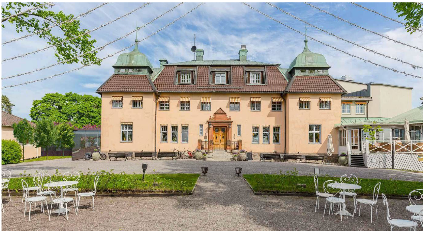
Huvudbyggnaden med den föreslagana glaslänken med leder till nya byggnaden ( foto från planbeskrivning).
