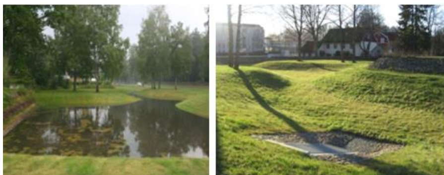
Figur 17. Skålade/nedsänkta grönytor vid vått respektive torrt väder. OBS! Djupet på den skålade ytan i bilderna är mycket större än de föreslagna 10-15 cm i denna utredning.
