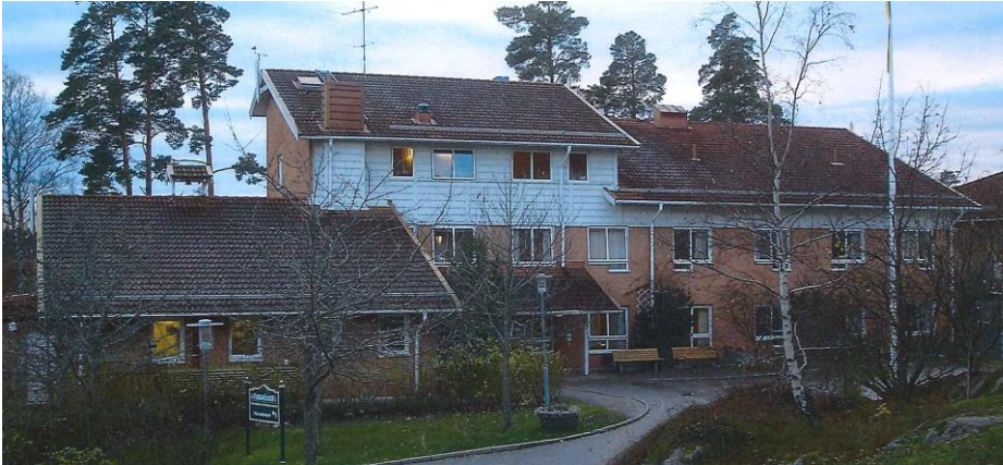
Den östra huvudbyggnadens norra fasad i sitt nuvarande utförande. Källa: Fastighets AB Furuhöjden.
