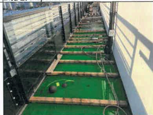
Bild 4: Bild tagen i samband med provocering av tätskikt med infärgat vatten.
