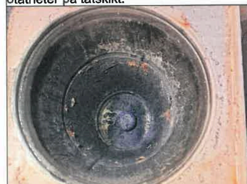
Bild 7: Bild på närliggande inspektionslucka innan provocering.
