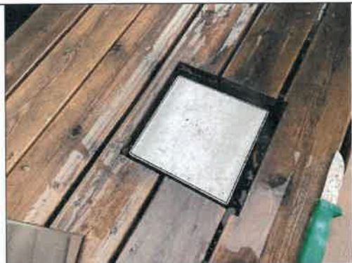
Bild 2: Inspektionslucka till ventilation.
