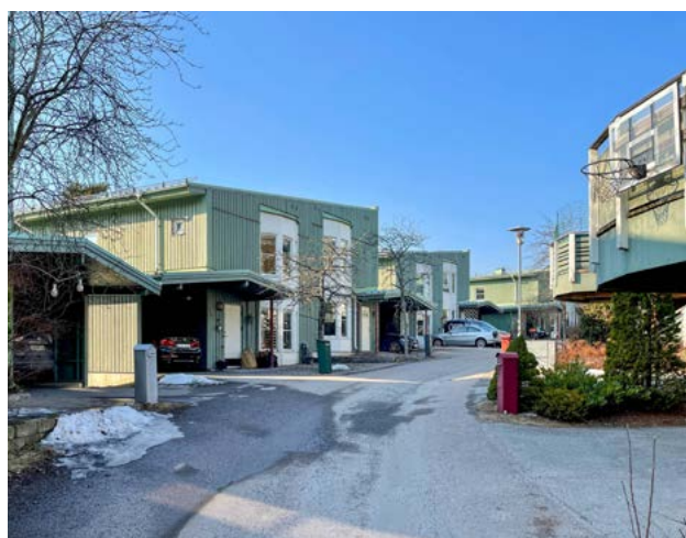
Kvarteret Buteljen, där parhusen ligger tätt intill Armébacken. Arkitekt Lars Starland, FFNS arkitektkontor.
