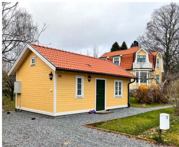
Komplementbyggnaden har samma färgsättning och fönstertyp som huvudbyggnaden, men har en enklare form på taket.
