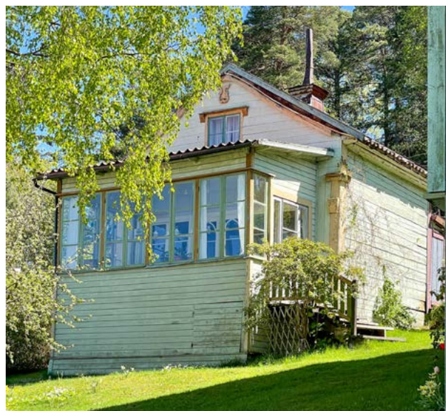
Templet är en timrad byggnad där knutarna brädats in och dekorerats med volutkapitäl. En glasveranda byggdes till år 1910.
