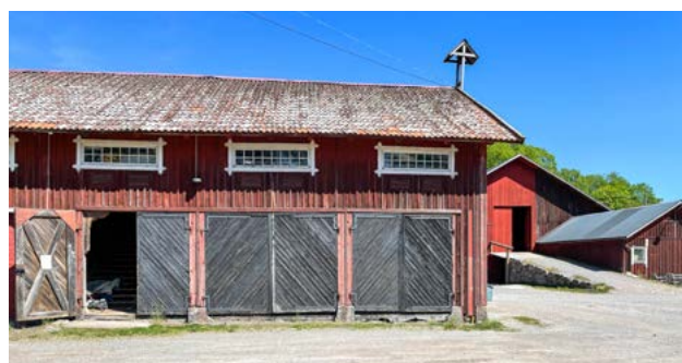
Såsta gård, ett vagnslider. Kraftiga konsoler av naturvuxet trä förstärker konstruktionen. Portarna är svarta, fasaderna av lockläktpanel är rödfärgade, småspröjsade fönster är vita.
