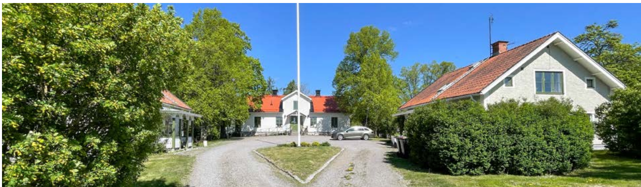
Karby gård, huvudbyggnaden och flygelbyggnaderna har tegeltäckta sadeltak, grovt spritputsade vita fasader, med slätputsade hörn och fönsteromfattningar.
