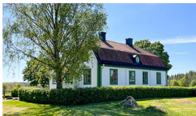
Såsta gård. Huvudbyggnaden har brutet och valmat tak, breda panelbrädor med läkt och inbrädade knutar. Fasaden är vit med mörkt gröna fönstersnickerier, foder och knutar.
