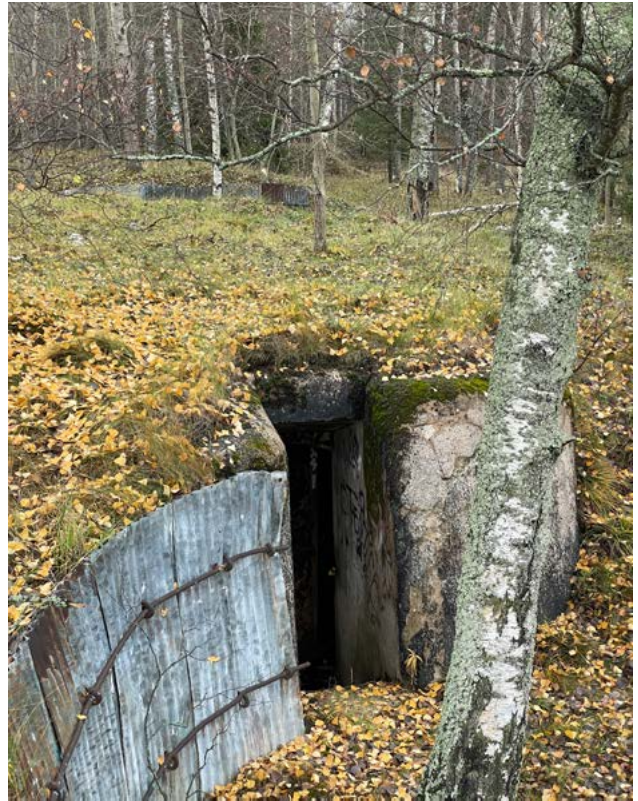
Karby batteri är en del av Norra fronten. Den består av fyra U-formade 140 meter långa pjäsplatser, granatskjul, krutmagasin och en förlägningsplats.
