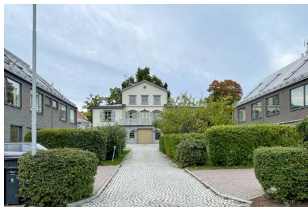
Norra Viggbyholm, i fonden en villa som år 1909 flyttades från Brunnsviken till Viggbyholm. Den var ursprungligen uppförd år 1838 och kallas Jaktvillan. Flygelbyggnaderna tillkom år 2006.
