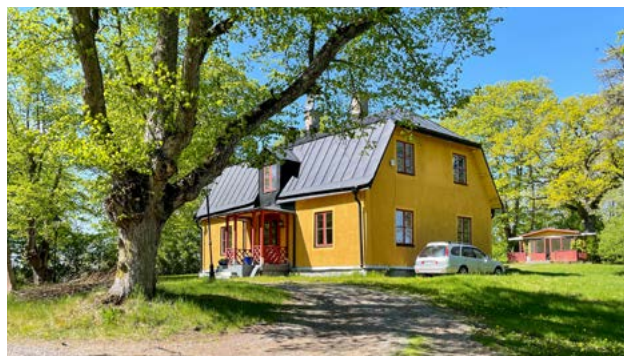
Hagby flygelbyggnad, troligen från 1700-talet. Stommen är av trä och utvändigt reveterad. Taket är brutet och valmat och täckt med svartmålad plåt.
