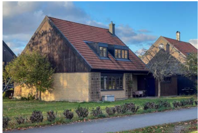
Kvarteret Hägern, elementhus byggda i mitten av 1970-talet. Bottenvåningen är utförd i tegel, den höga gaveln i träpanel.
