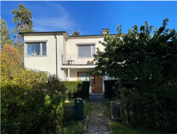
En villa i Näsbypark byggd 1940 i funktisstil. Takfallen är låga och syns inte från gatan. Fönsteröppningarna horisontella och placeras ofta över hörn. Fasaden har slät vit puts.
