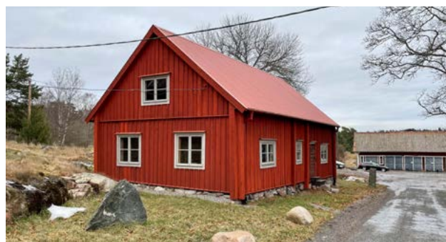
Löttinge gård, höns huset som har renoverats har väggmålningar invändigt.
