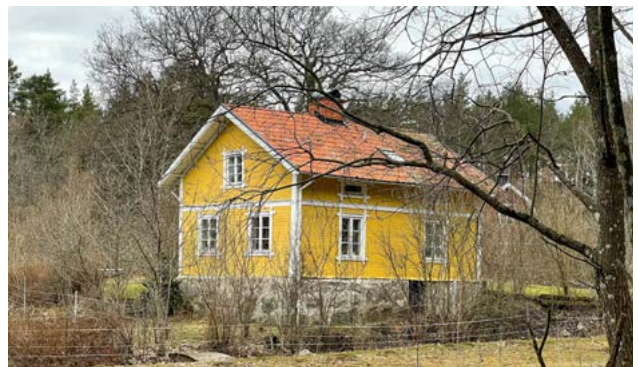
Marielund har två boningshus byggda vid sekelskiftet 1900 eller tidigare. Tvåluftsfönstren har spröjs och dekorativa foder.
