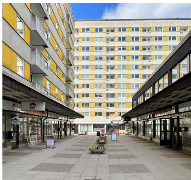
Hägernäs centrum, med ett intimt torg mellan höga skivhus uppförda åren 1962–1963 samlar butiker och närservice.
