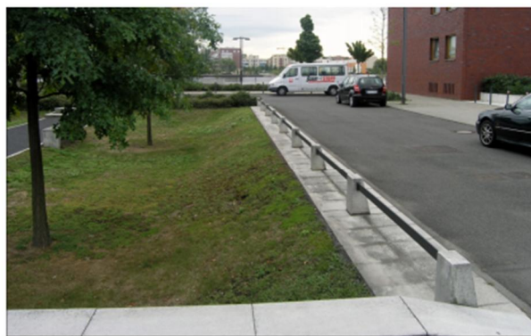
Figur 13. Principskiss (vänstra bilden) för svackdike. Exempel på svackdike där vatten leds på bred front från överlöpingsyta till svackdike (högra bilden). (Källa: SVOA, 2019)
