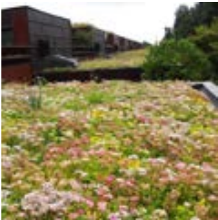
Blommande sedumtak (Foto Byggros)
