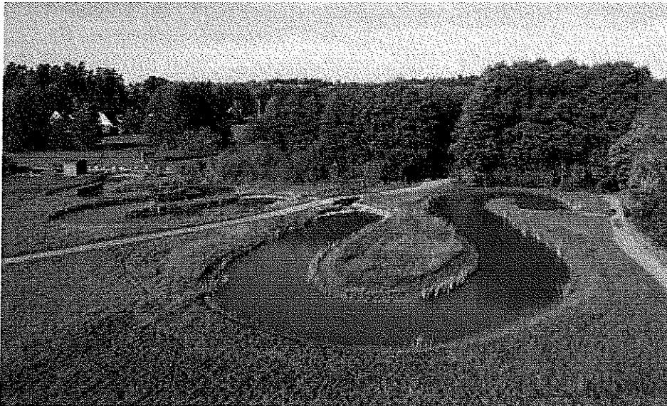
Reningsanläggning för dagvatten Hästängen Gribbylund
